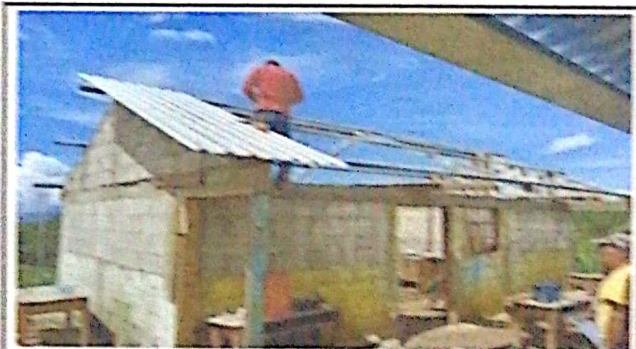
Foto 4: ampliación de la cocina
