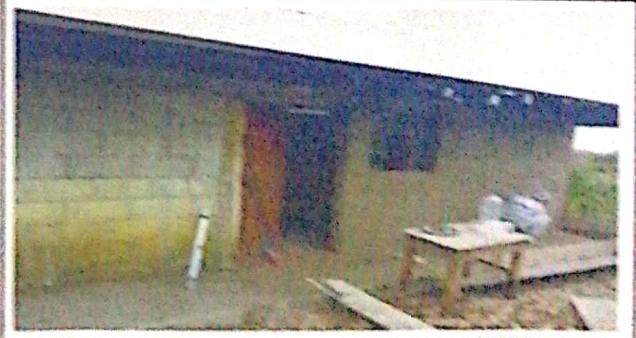
Foto 6: ampliación de cocina
