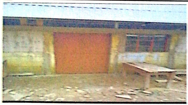
Foto 3 se muestra en la fotografía cambios puerta
